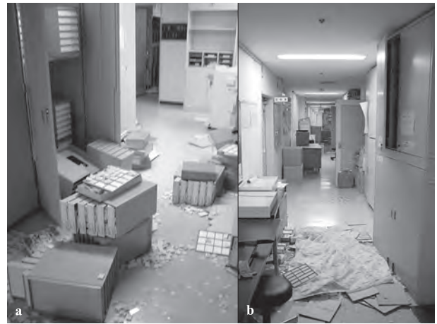
図3 震災直後の廊下。施錠していなかった棚からブロック(a)や標本(b)が落下し破損したが、施錠していた棚の扉は開かなかった(b)。
